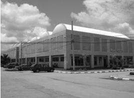
ภาพประกอบ 1 อาคารบริการกลาง (พลาซ่า) ศูนย์กลางของการพาณิชย์รวมหลัก
